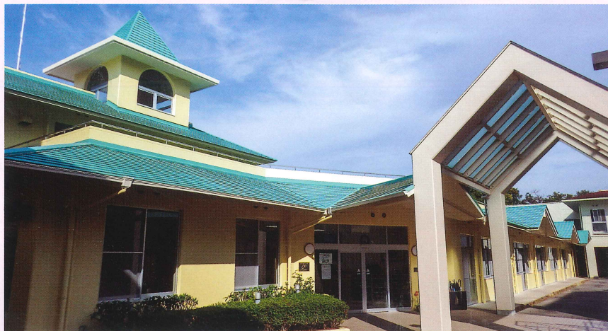
補修工事完了後の美山苑
